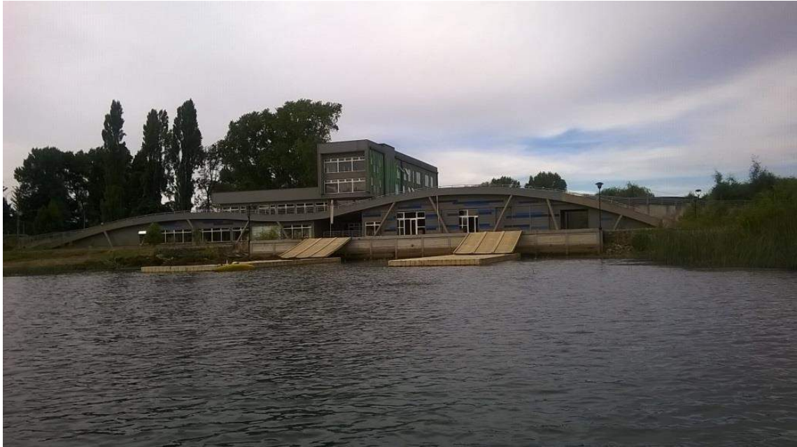
FOTOGRAFÍA 29: CAR NÁUTICO EN SECTOR LAS ÁNIMAS RIBERA NORTE DEL RÍO CALLE-CALLE. 2014.
