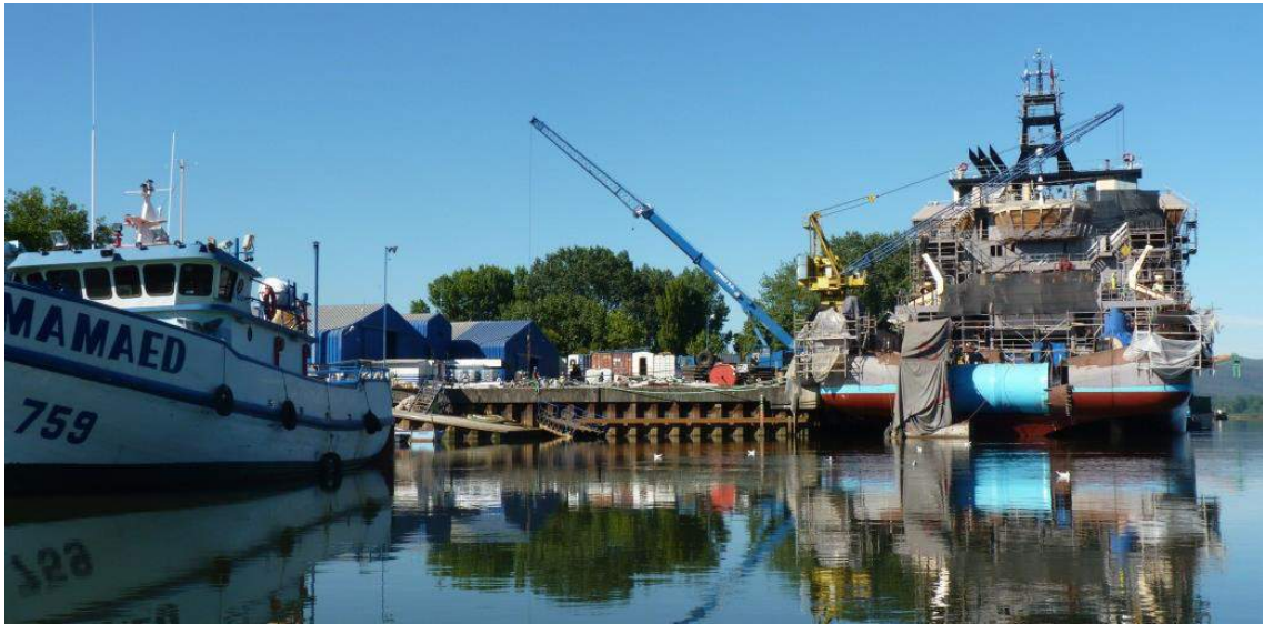
FOTOGRAFÍA 30: ASTILLEROS Y VARADEROS EN CANAL HAVERBECK.
