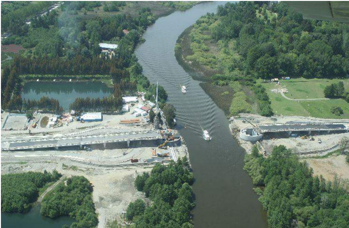
FOTOGRAFÍA 28: RÍO CAU-CAU Y CONSTRUCCIÓN DE PUENTE BASCULANTE, 2013.
